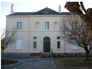
Maison paroissiale 23 rue de la Ville-en-Pierre
